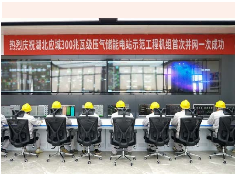
▲ 湖北应城 300 兆瓦级压气储能电站示范工程首次并网一次成功
