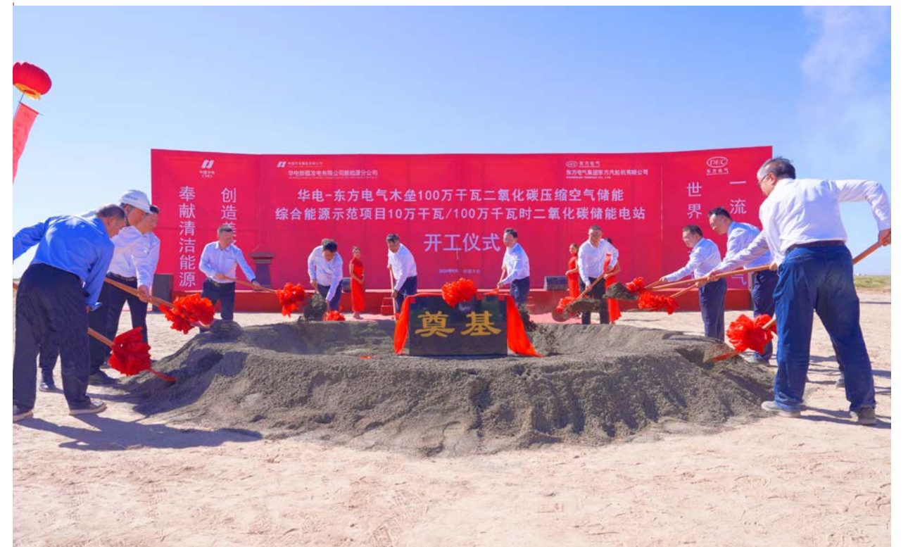
▲ 华电 - 东方电气木垒 100 万千瓦二氧化碳压缩空气储能综合能源示范项目在新疆昌吉州木垒哈萨克自治县举行开工仪式
