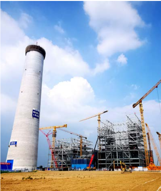
▲ 大唐郓城煤电项目
