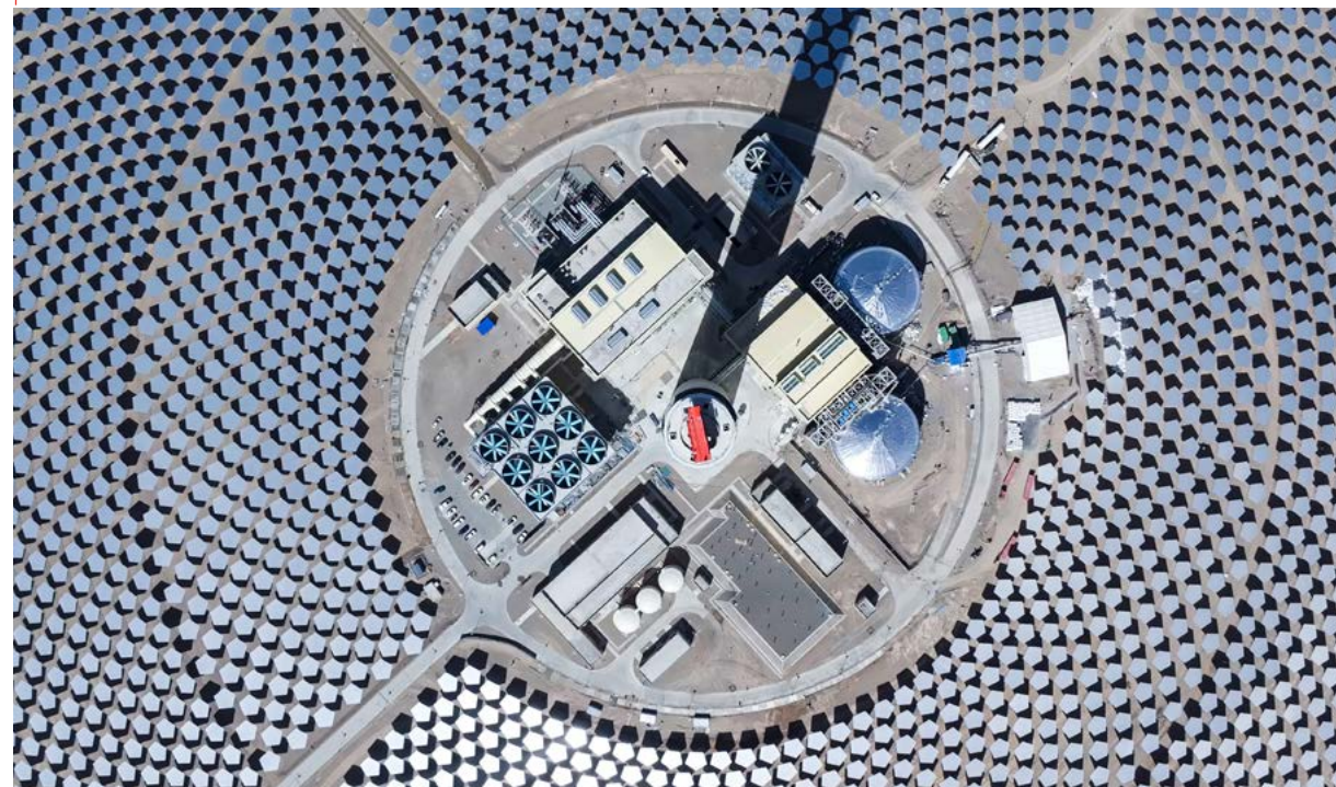
▲ 甘肃阿克塞汇东新能源 110 兆瓦光热 +640 兆瓦光伏试点项目
